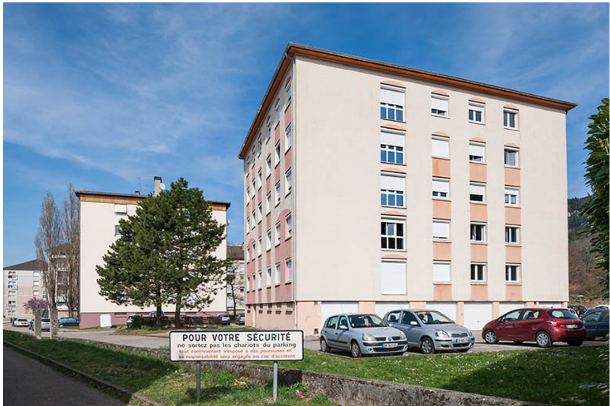
Angle sud-ouest du bâtiment des pinsons.
