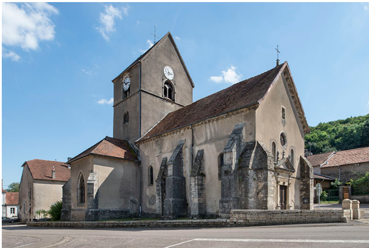
Vue avant restauration (2016).
