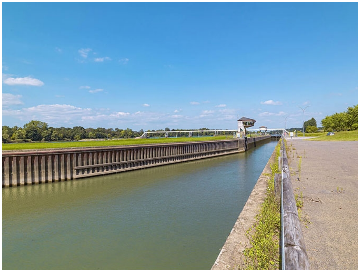
Le sas vu d'aval.
