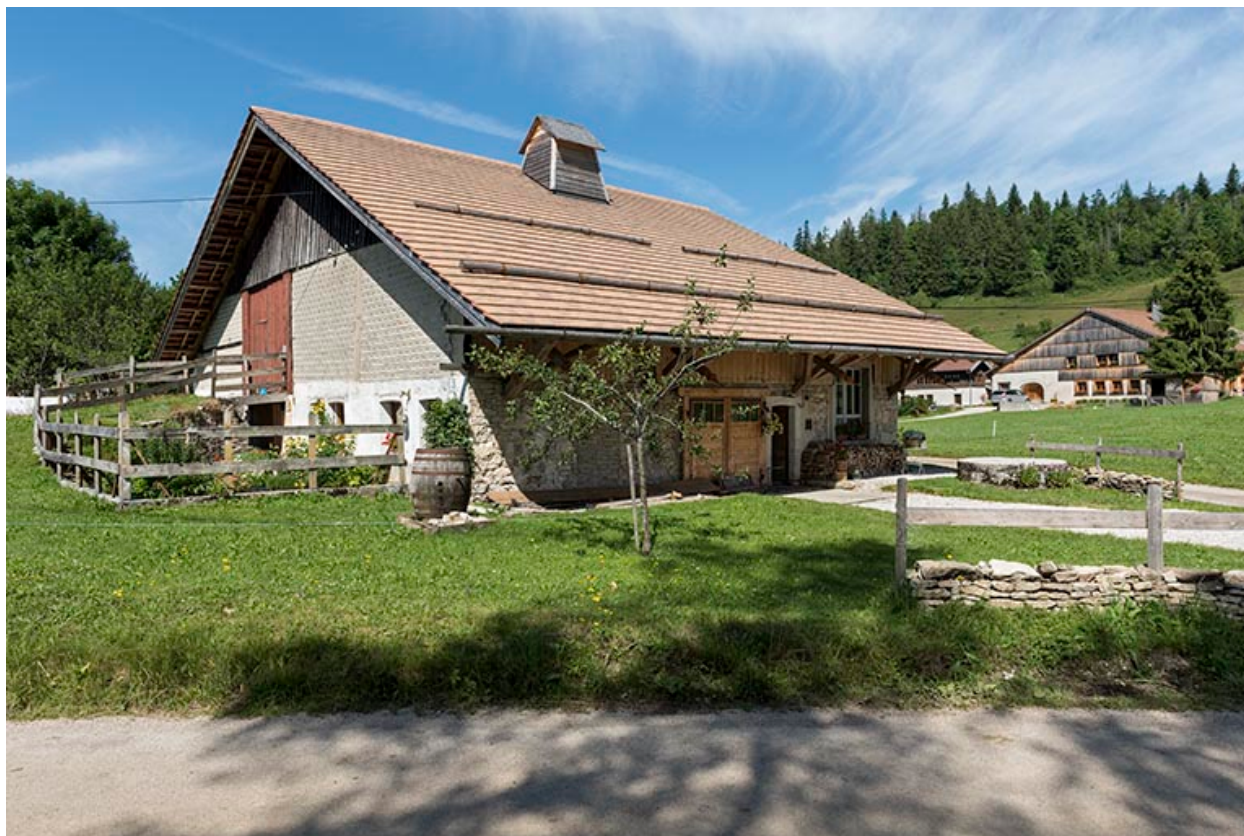
Façades antérieure et latérale gauche.
