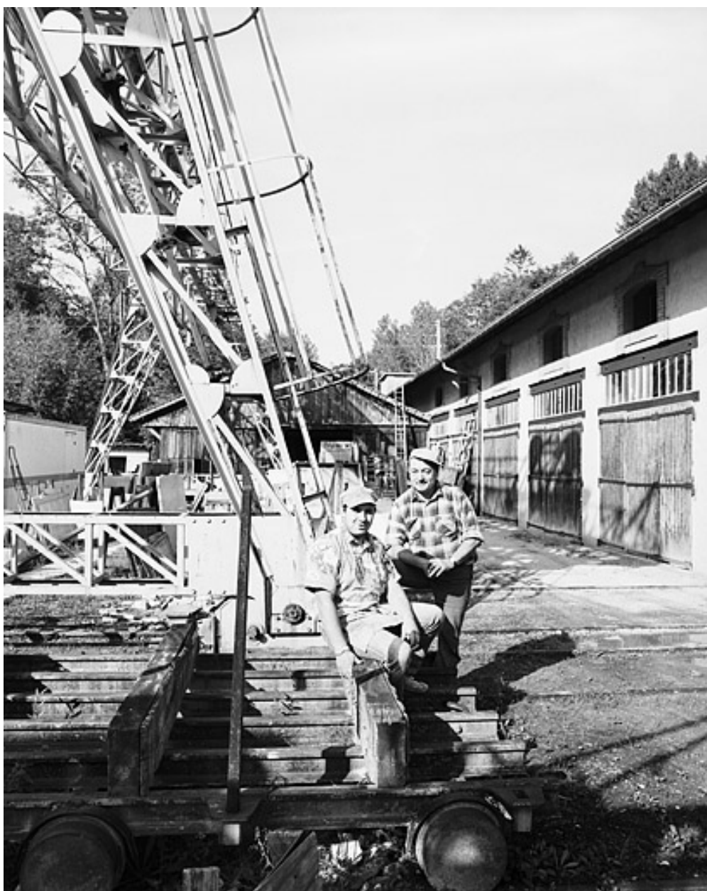
Ouvriers au pied du portique roulant.
