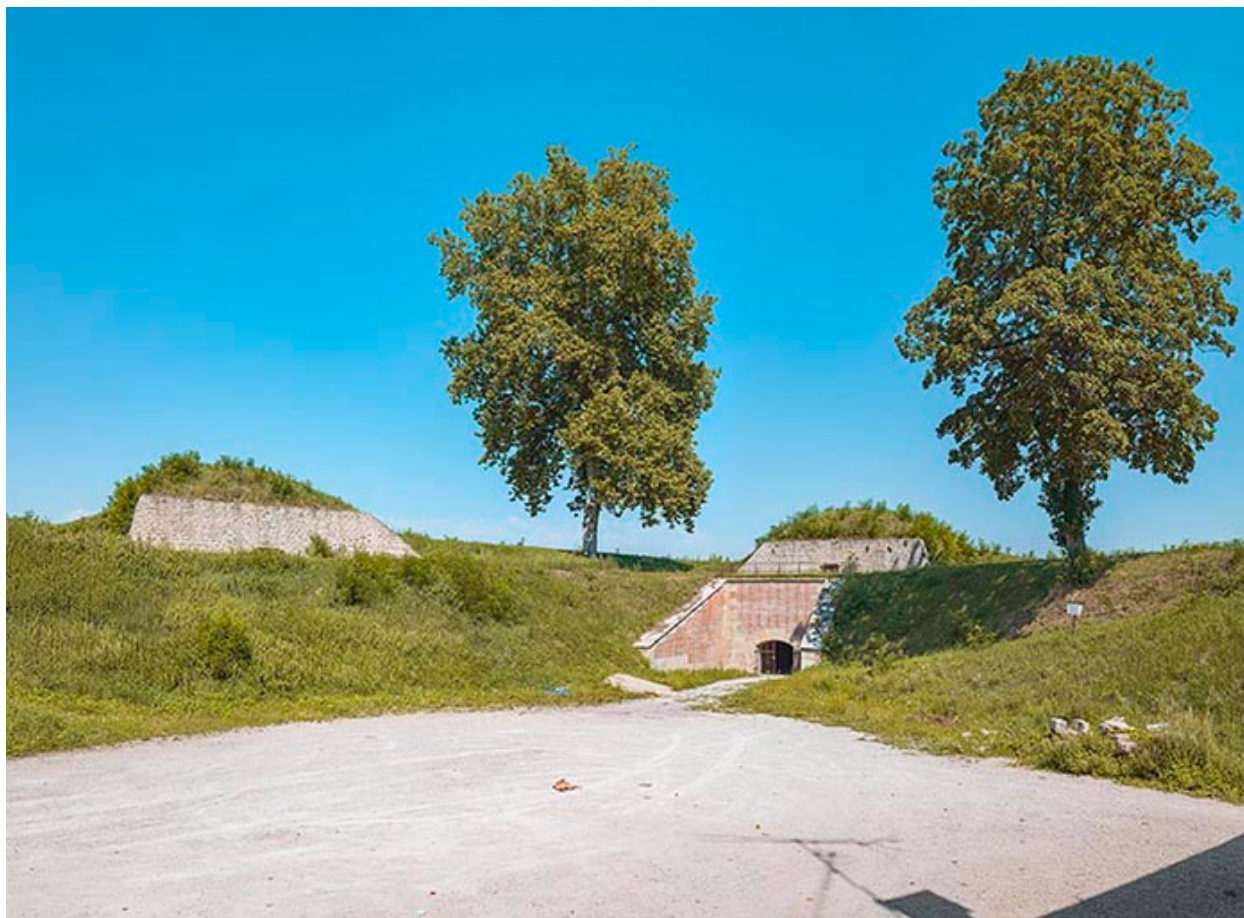
Vue générale du bastion depuis sa gorge.
