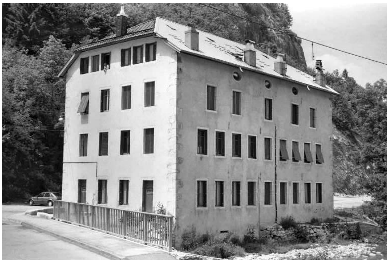
Façades antérieure et latérale droite.
