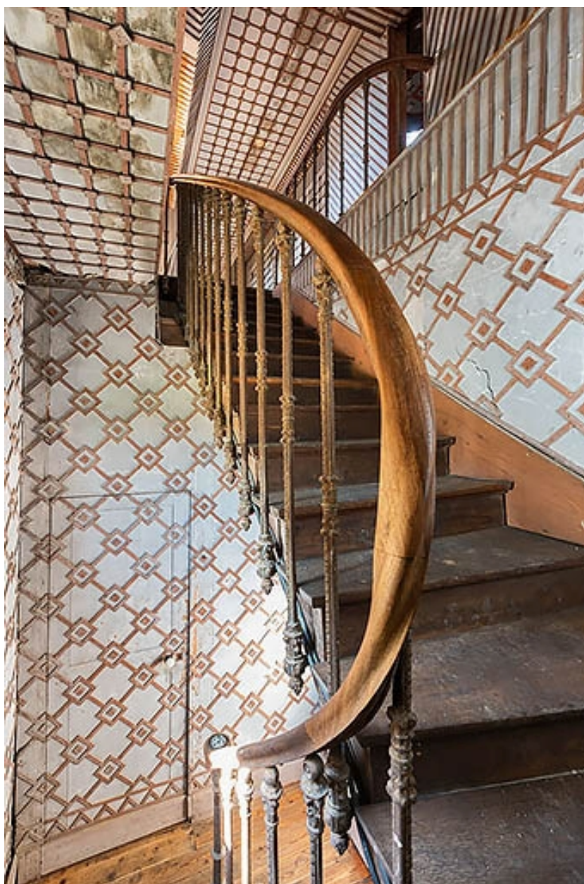
Corps nord (théâtre) : escalier d'accès au balcon.
