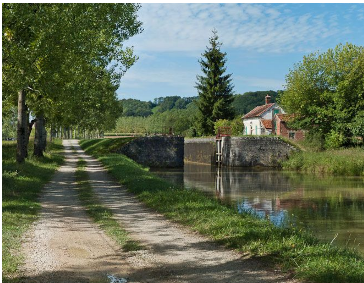
Vue du site d'écluse depuis l'aval.
