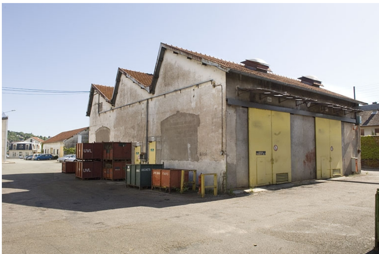
Salle des machines et chaufferie (usine Dollé).
