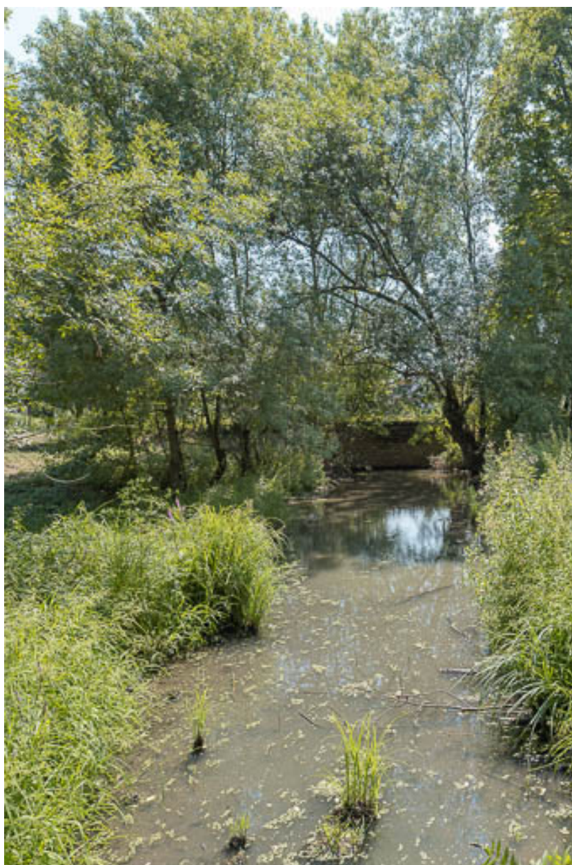
Vue du ponceau et du site.
