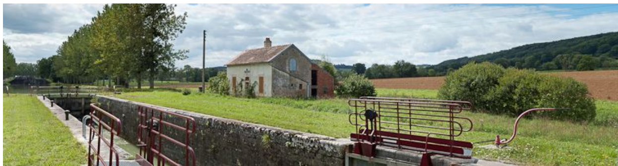
Vue d'ensemble du site d'écluse.
