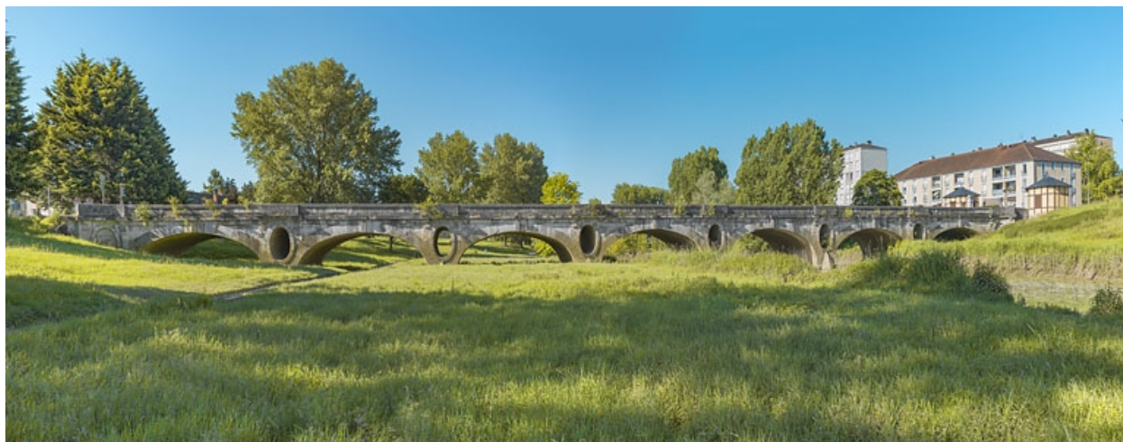
Vue d'ensemble du pont des Chavannes.
