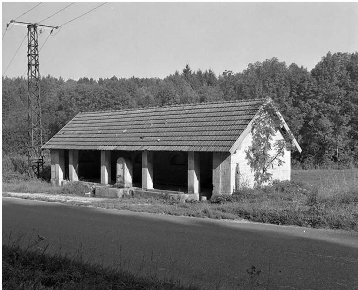
Fontaine-lavoir située rue de l'Eglise.
