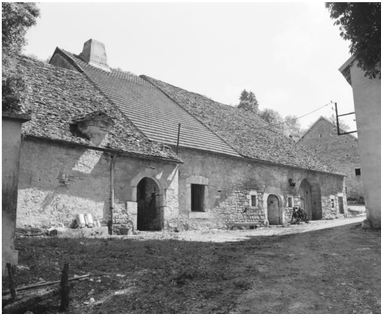
Façade antérieure de ferme.
