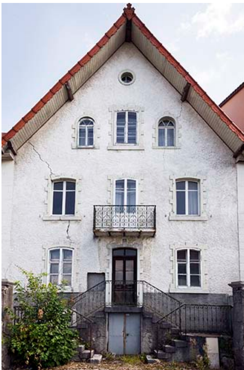
Bâtiment des années 1914-1918 : façade antérieure.
