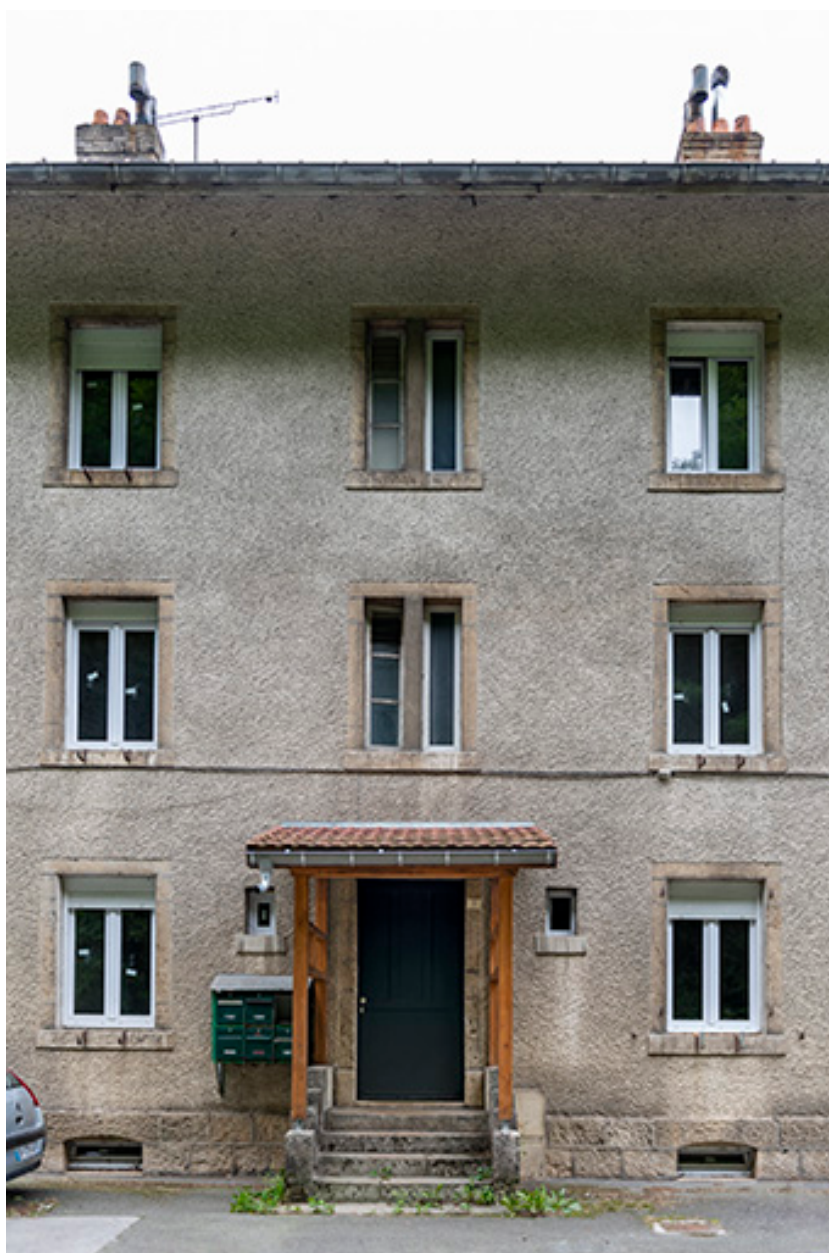
Immeuble, façade antérieure : entrée du n° 10.
