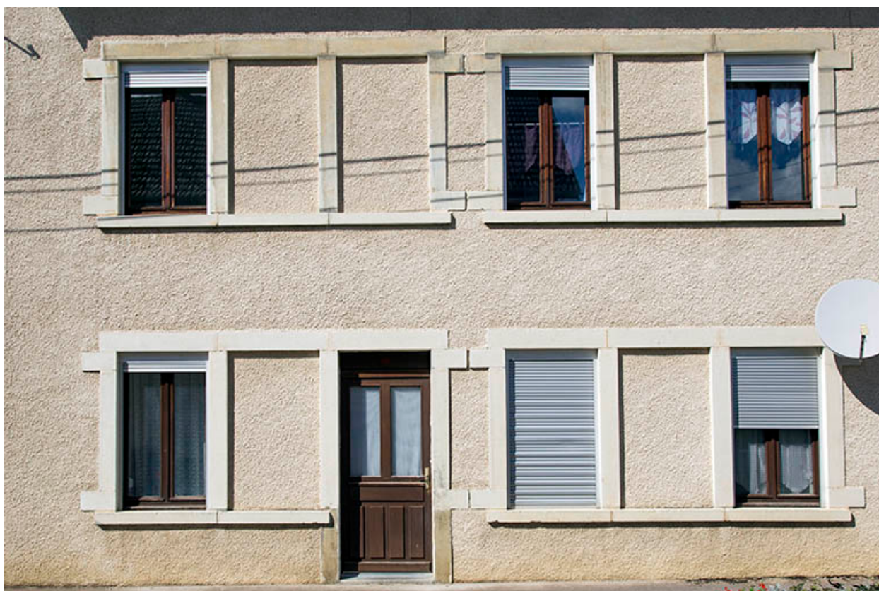
Façades antérieure des ateliers.
