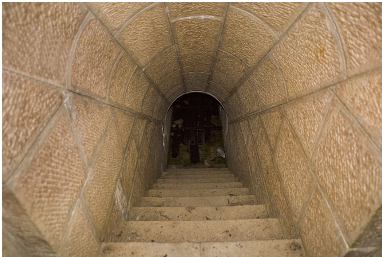
Chambres de mine centrale : escalier.
