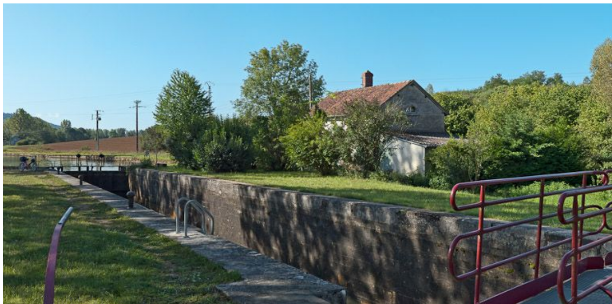
Vue d'ensemble du site d'écluse.
