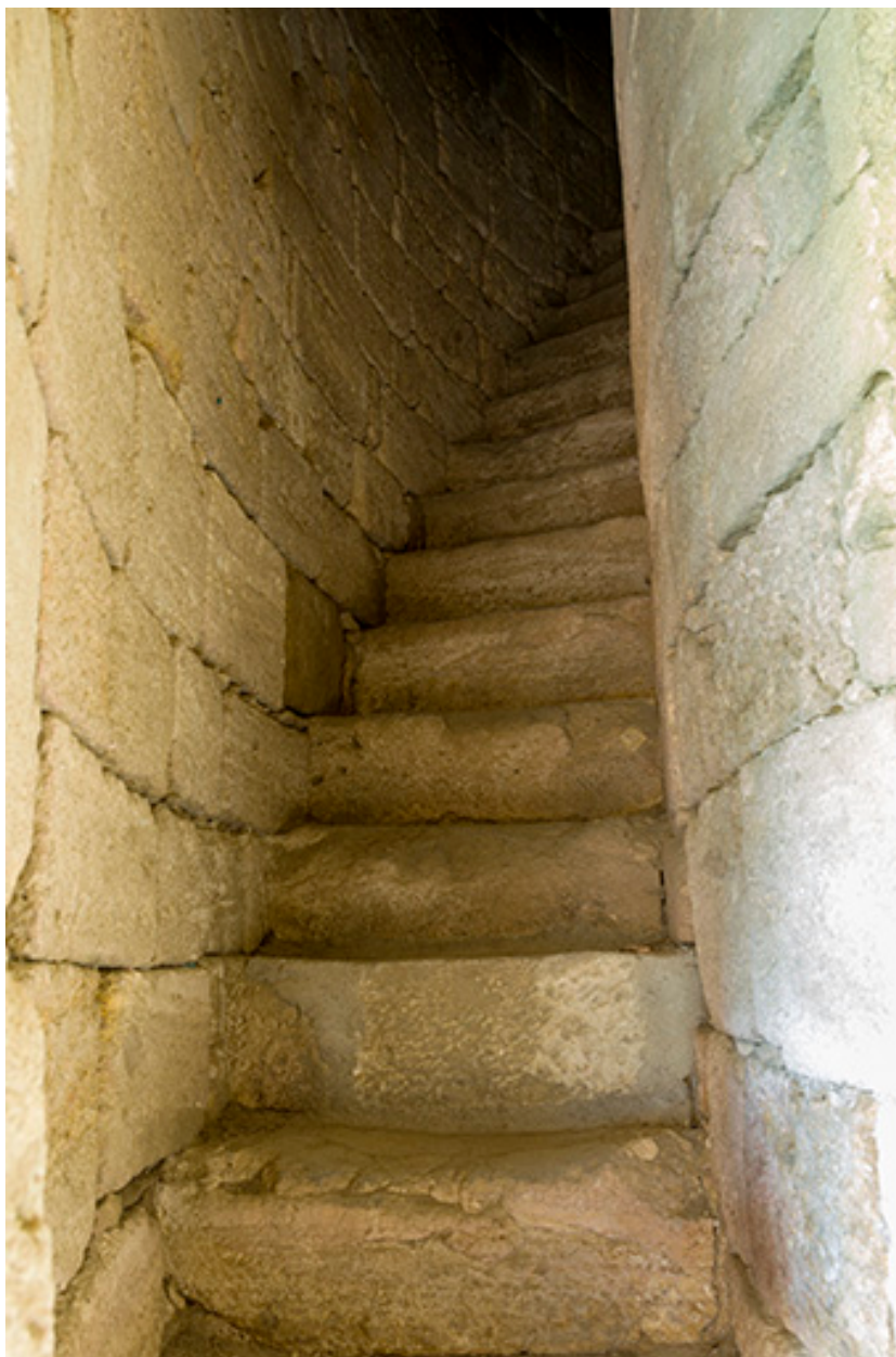
Intérieur du donjon : l'escalier en pierre.
