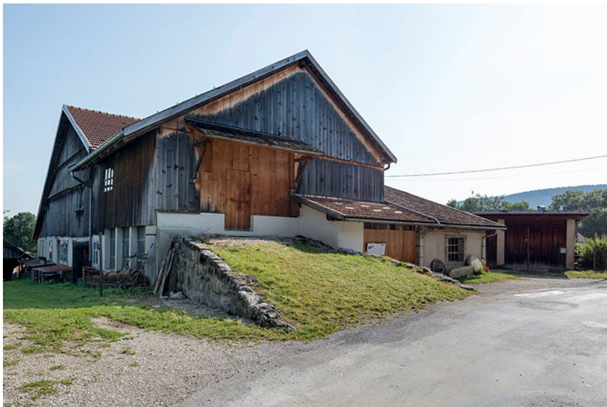
Façades latérale gauche et postérieure.
