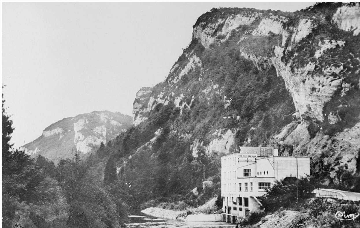
Chassal (Jura). Centrale électrique de St-Claude.
