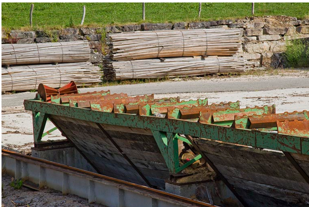
Parc aux grumes : détail du convoyeur.
