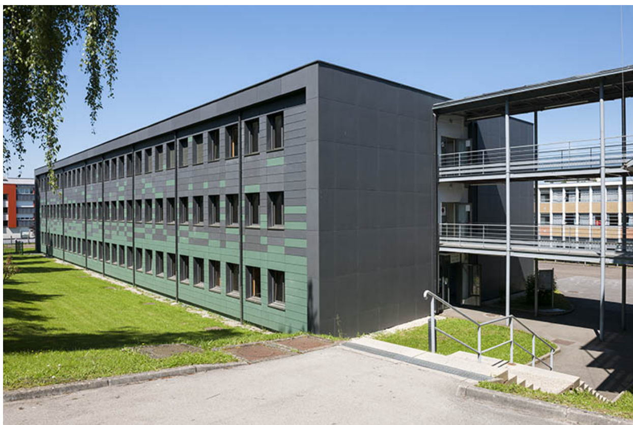
Façade sud et pignon est de l'externat.
