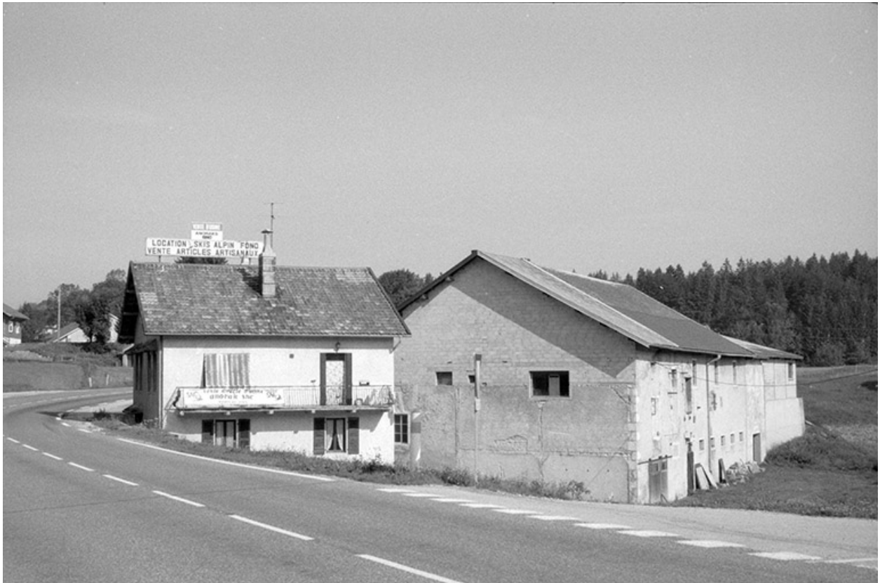
Logement patronal et ateliers de fabrication.
