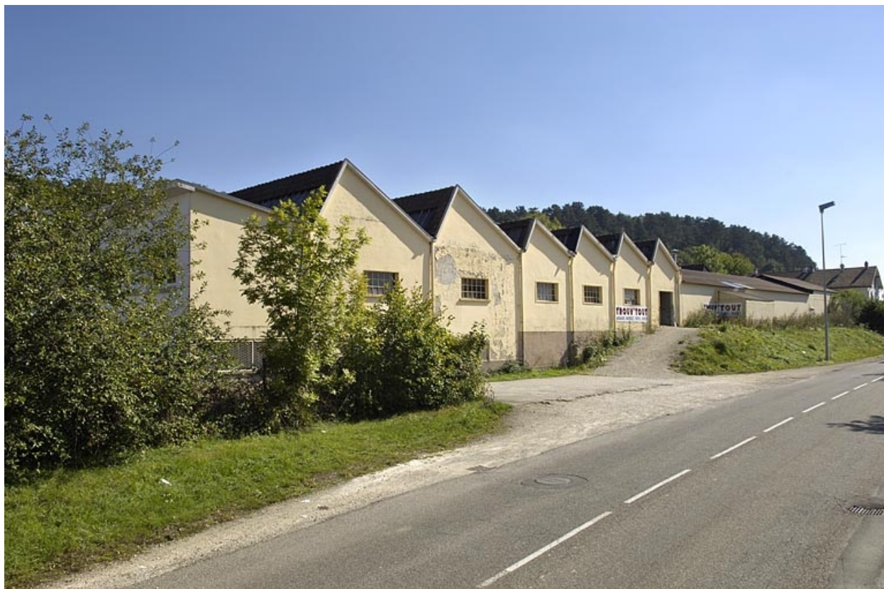
Façade sur rue de l'atelier de fabrication.
