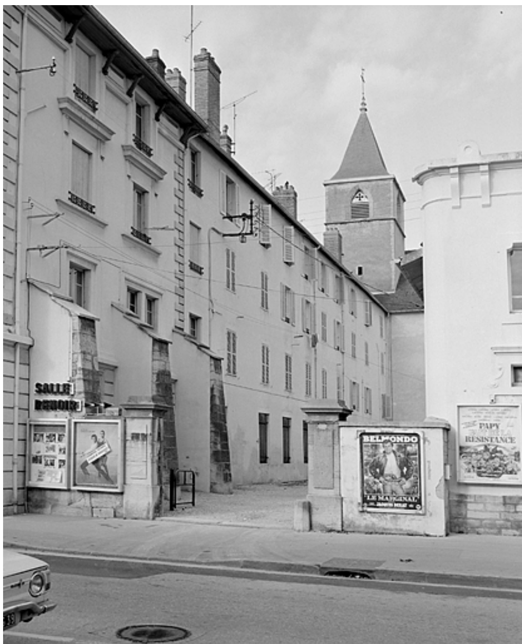
Anciens bâtiments conventuels. Façade latérale est.
