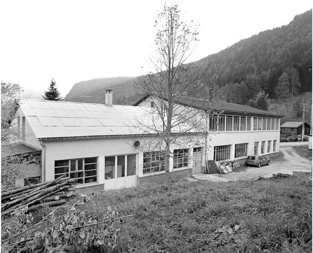
Vue d'ensemble depuis le nord : élévation postérieure.
