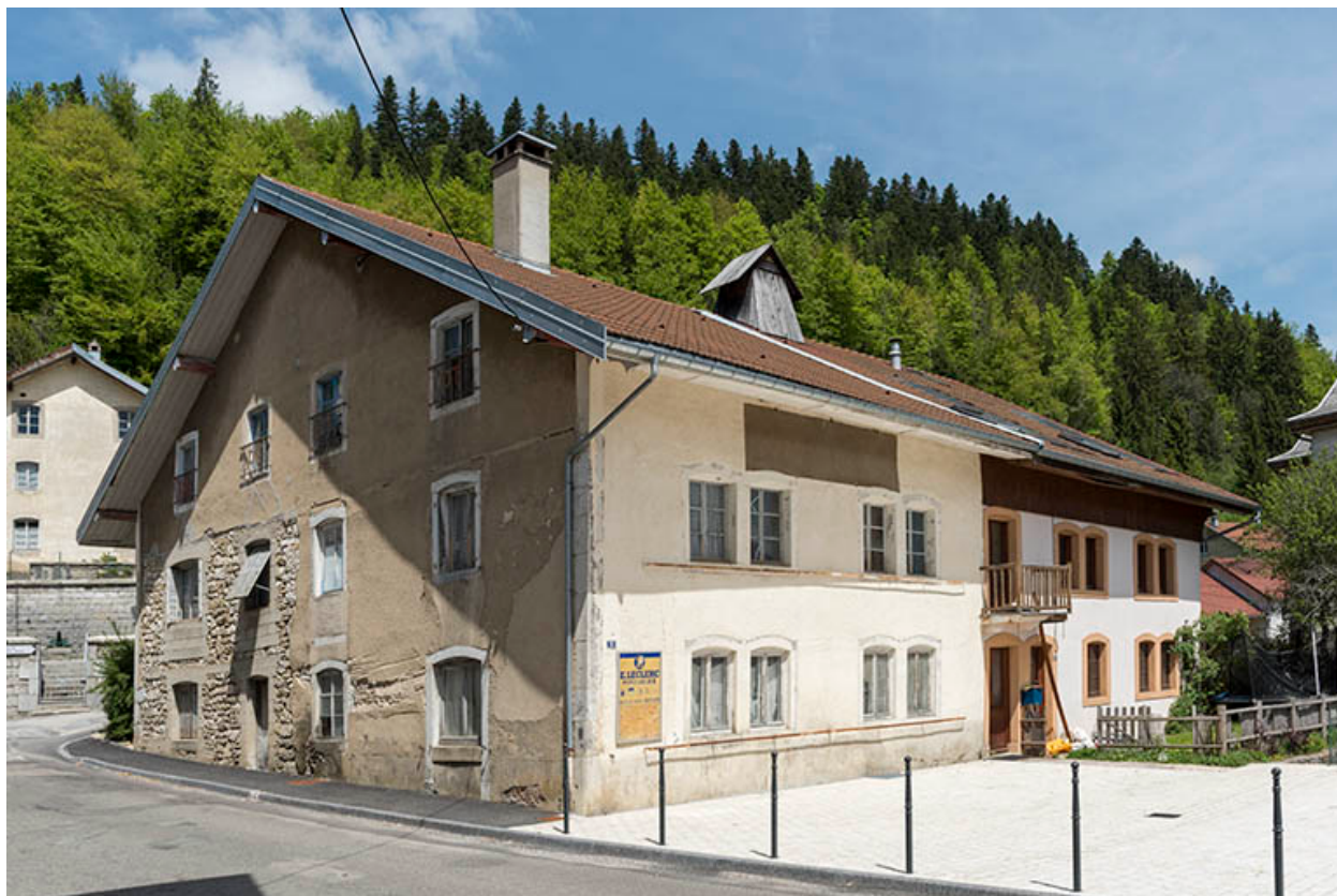
Façades antérieure et latérale gauche.
