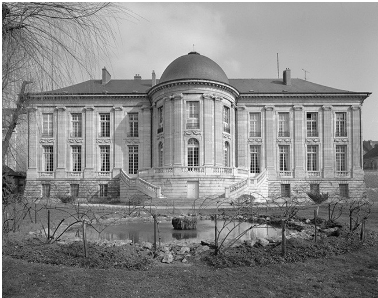
Façade postérieure, de face.
