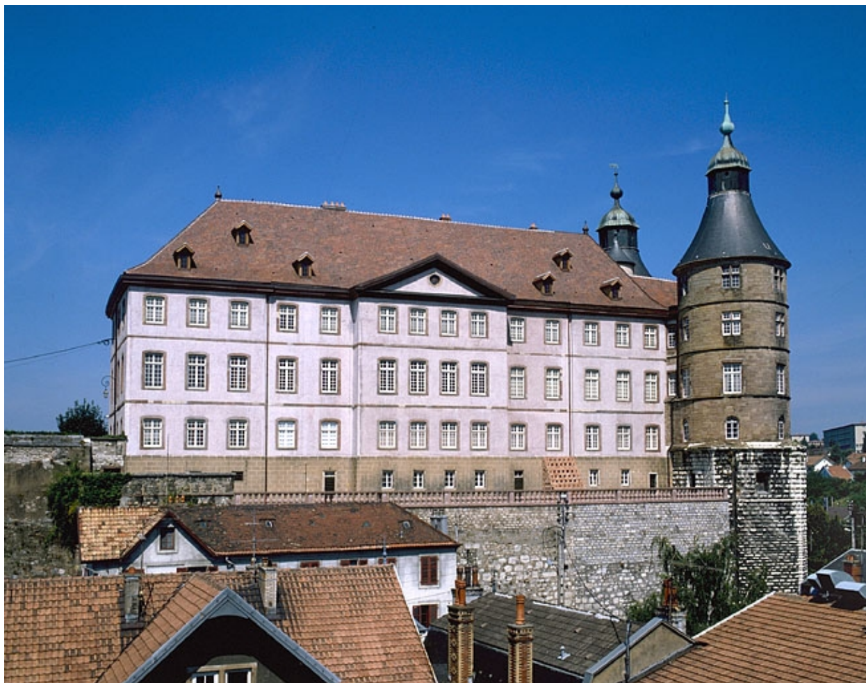
Corps de bâtiment principal. Côté sud.
