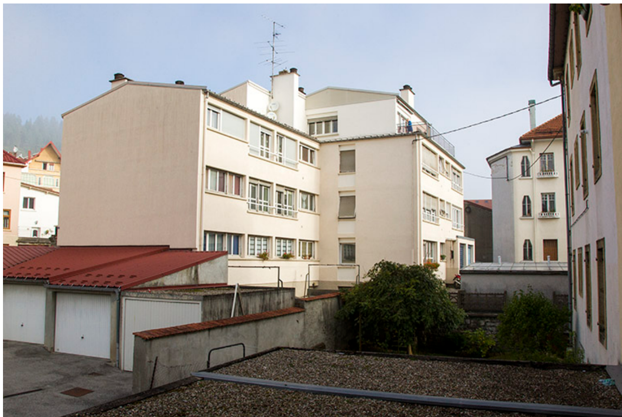
Bâtiment sud : vue d'ensemble, depuis le sud.
