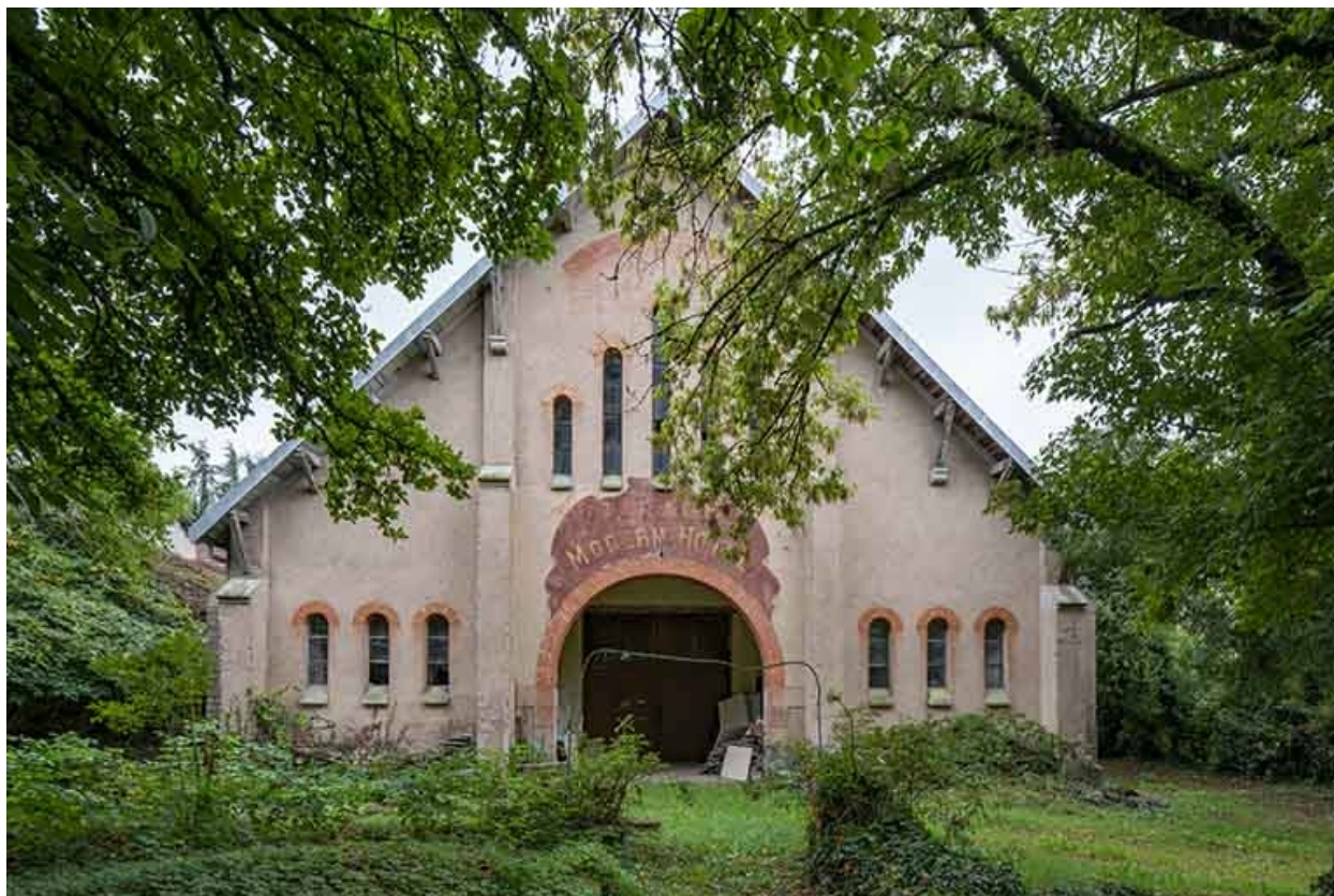
Mur-pignon nord, vue de face.
