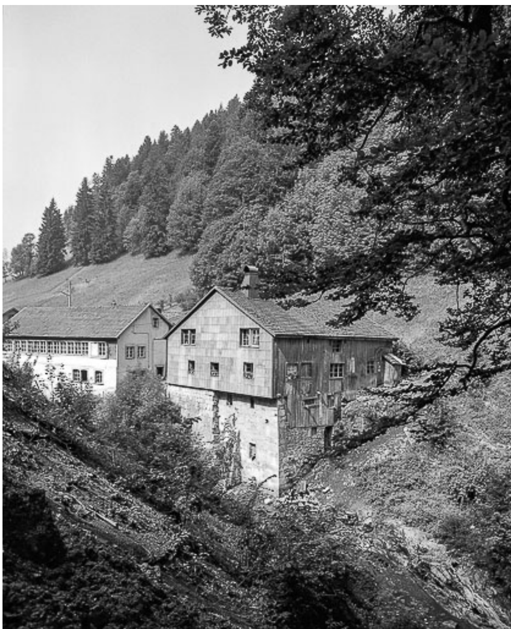
Vue d'ensemble, depuis le nord-est, en 1976.
