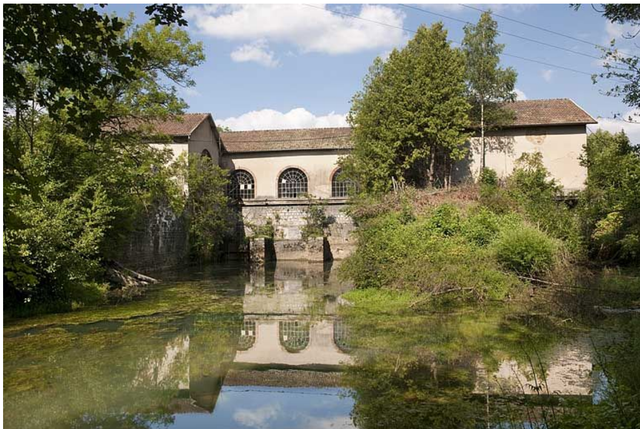
Vue d'ensemble depuis l'aval du bief.
