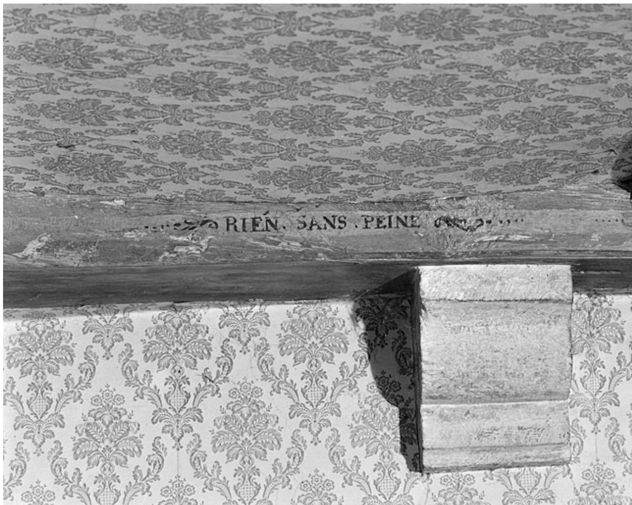
Premier corps de bâtiment. Plafond du rez-de-chaussée.
