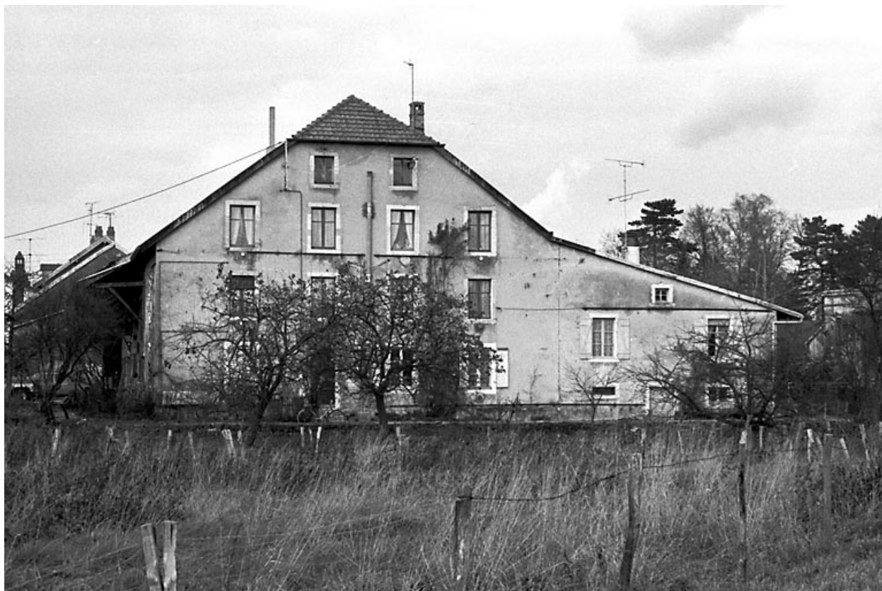
Vue du pignon droit de l'habitation.
