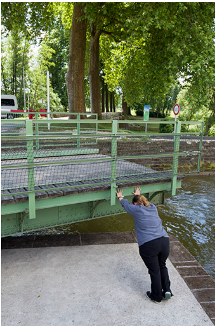
Rotation du pont par poussée manuelle.
