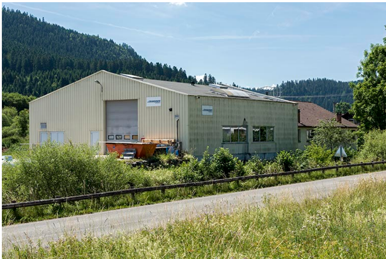
Façades postérieure et latérale droite.
