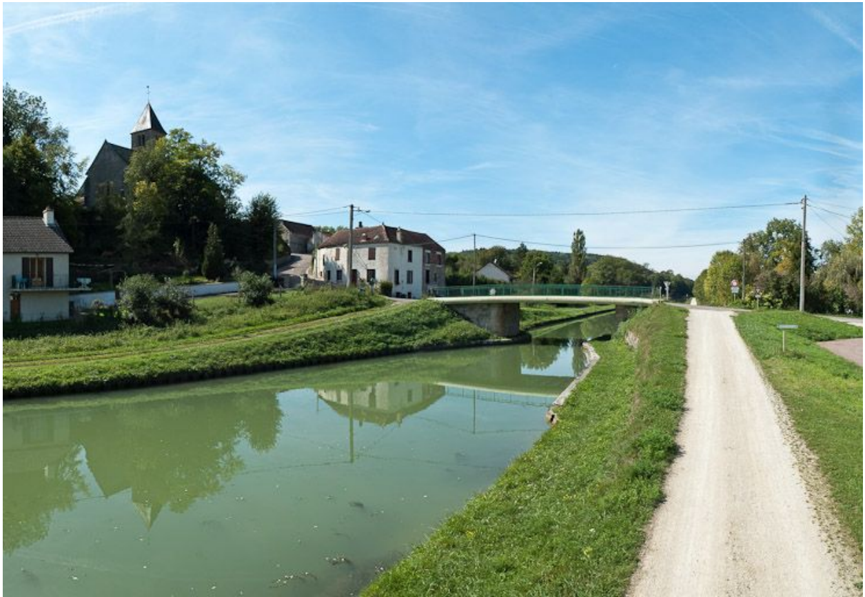
Vue du pont.
