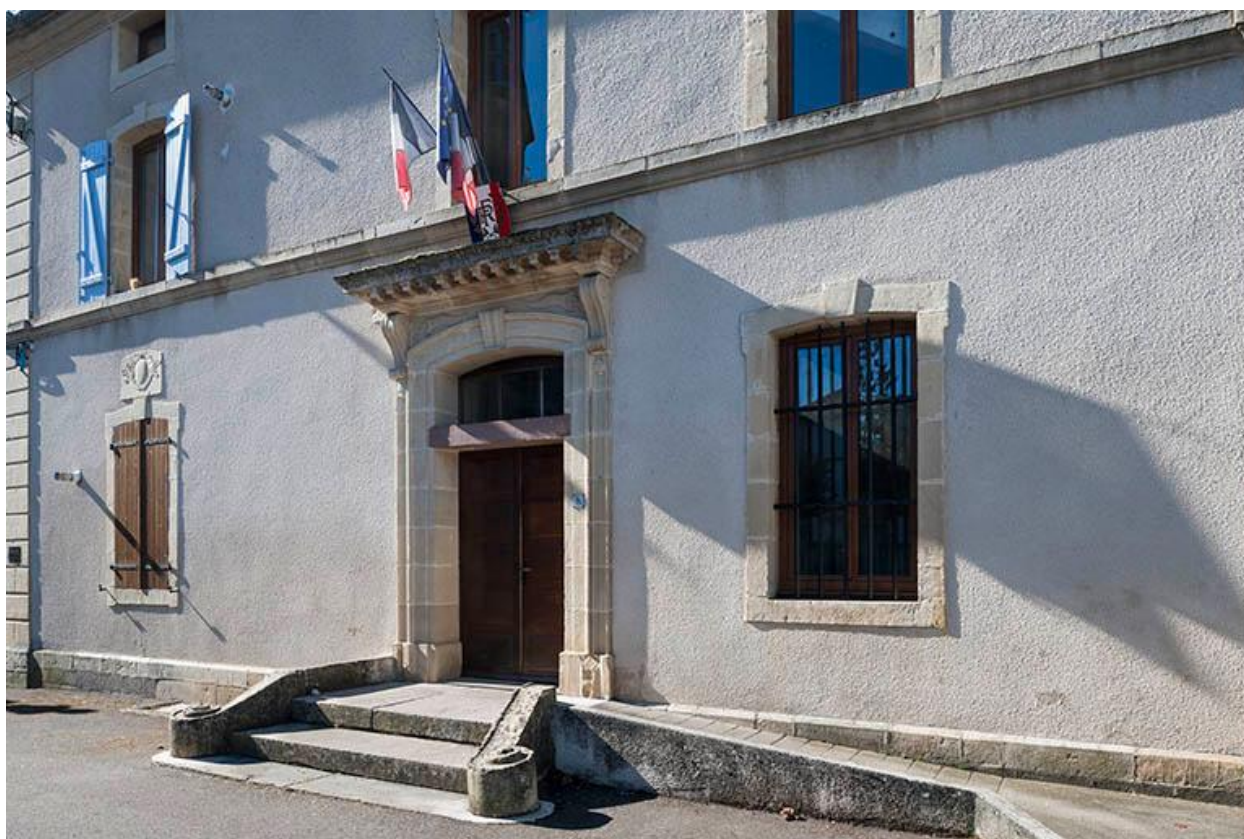
Entrée de la mairie, façade Nord.
