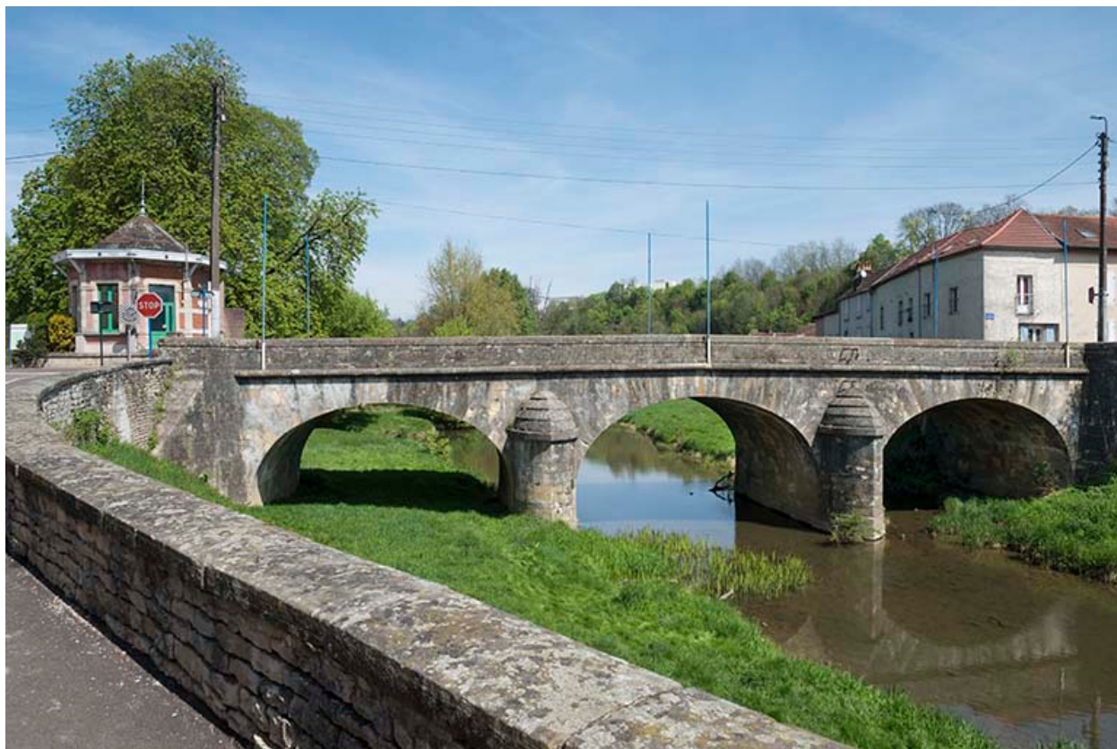
Le pont au niveau de la Rezelle.
