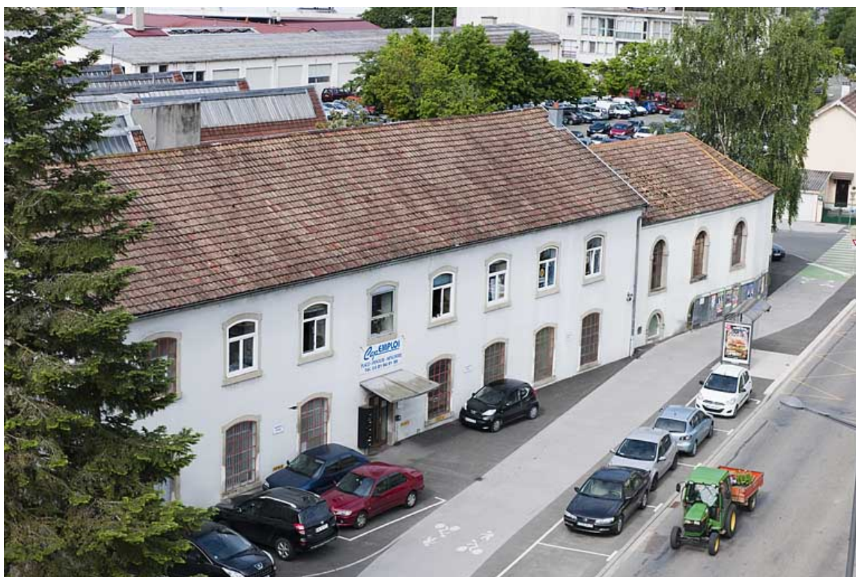
Vue plongeante sur le bâtiment administratif (?).
