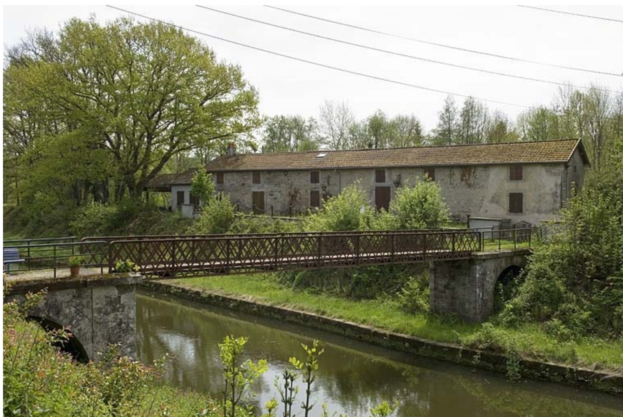
Vue d'ensemble du logement ouvrier collectif (est).
