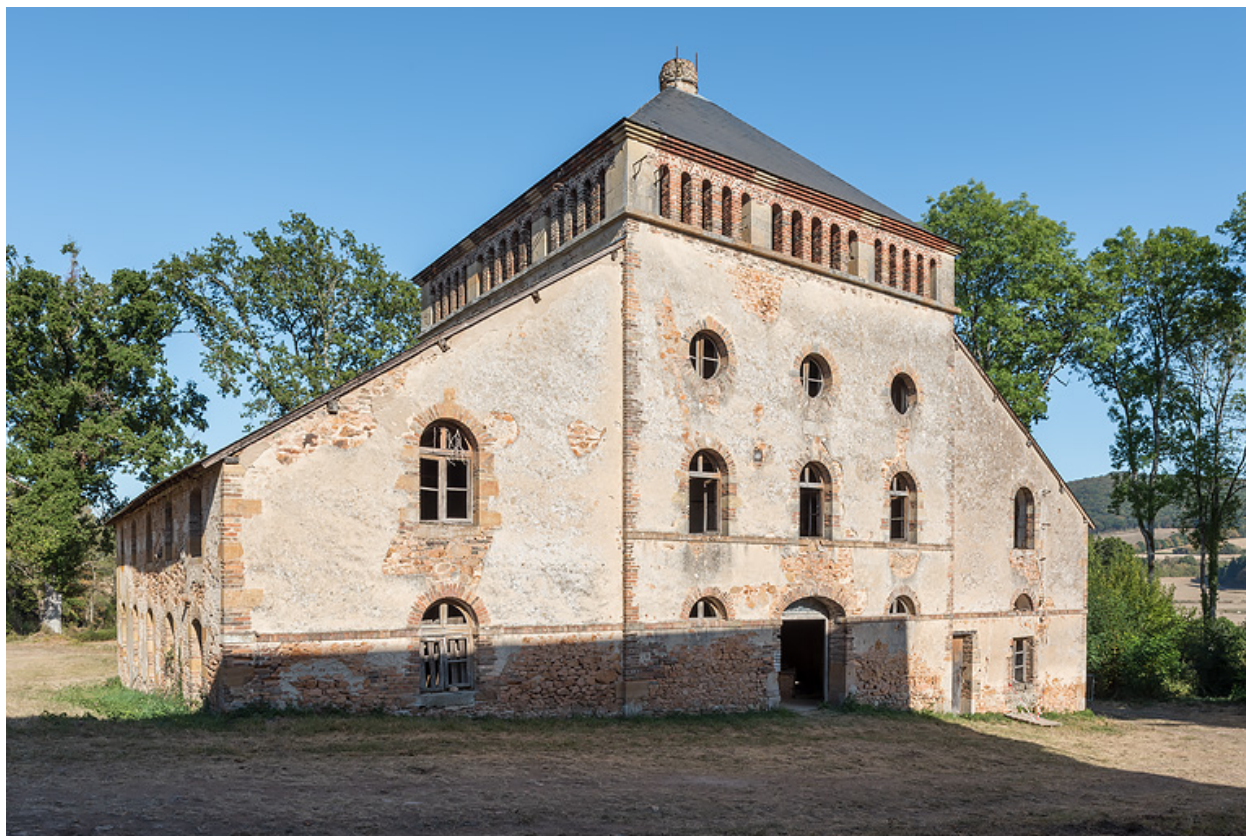
Vue depuis l'ouest, état actuel.
