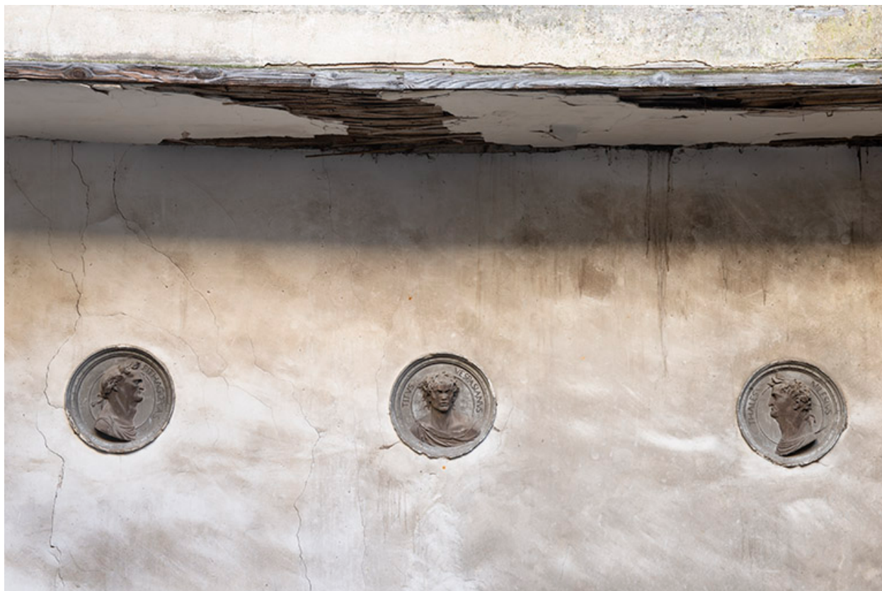
Médailles enchâssées dans le mur sud.
