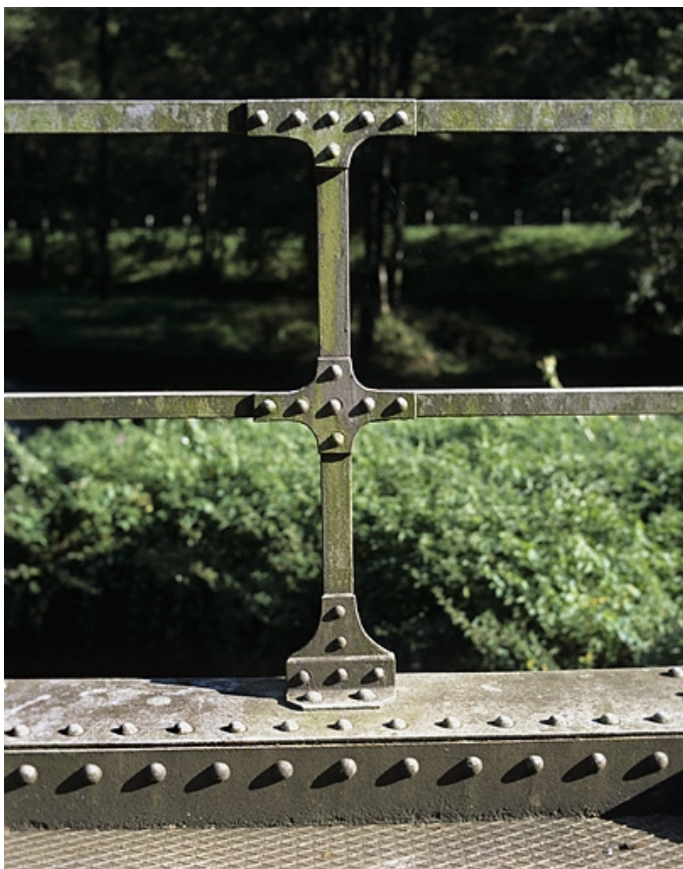
Pont : détail du garde-corps.
