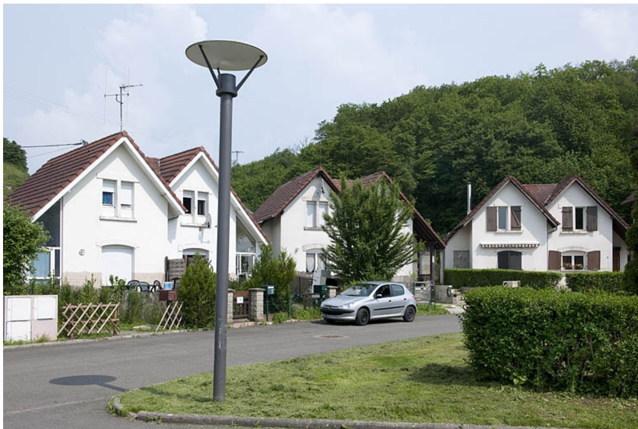
Cité du parc : maisons individuelles depuis l'ouest.
