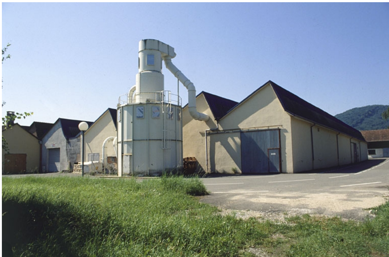
Extrémité nord des ateliers de fabrication.
